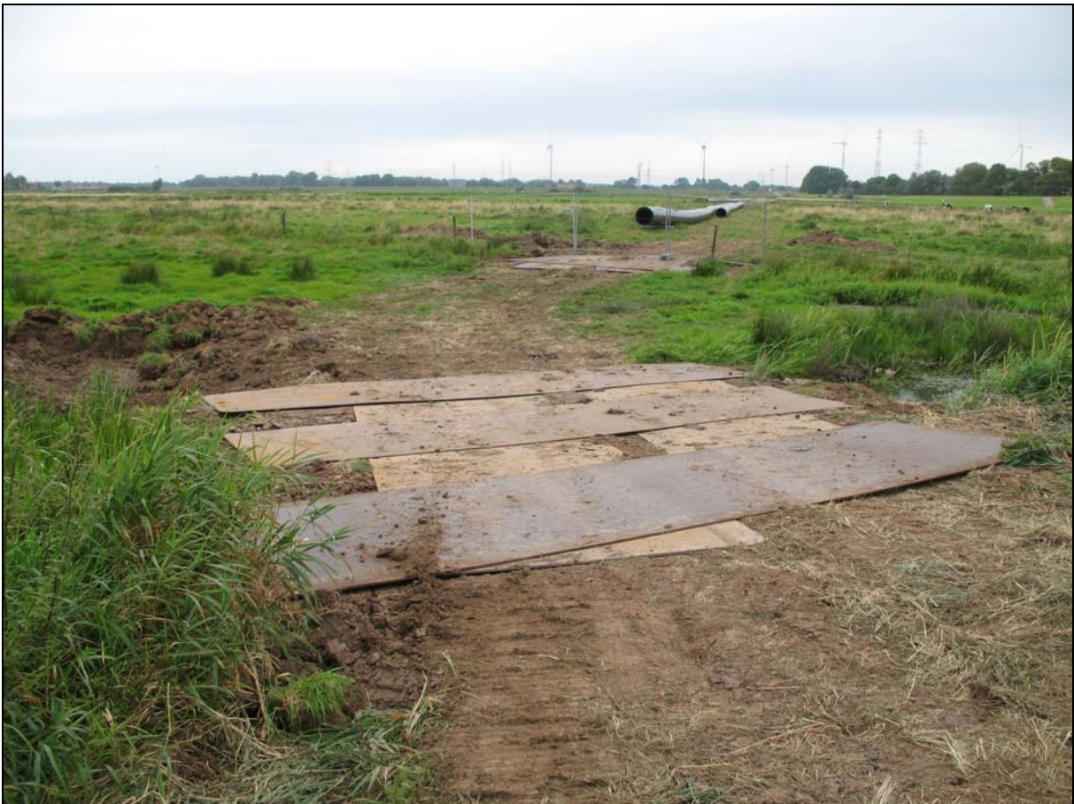
Abb. 6: Bauarbeiten zum Austausch der Klärwasserleitung (30.08.2007)
