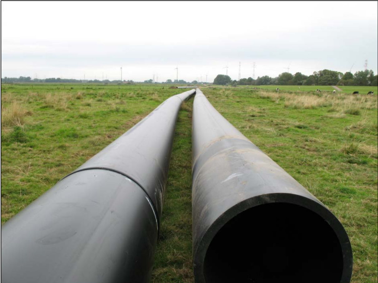
Abb. 7: Bauarbeiten zum Austausch der Klärwasserleitung (30.08.2007)
